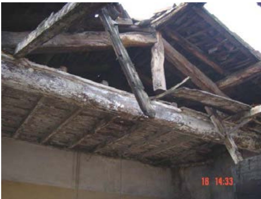
Particolare della struttura di copertura a capriata
