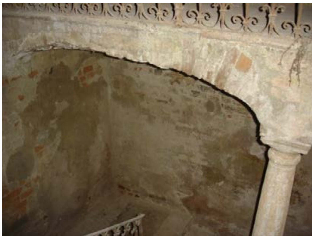
Volta di sostegno del ballatoio al piano primo
