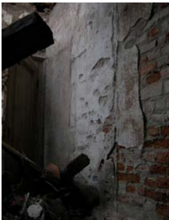
Fig. 17 - Villa Torri. Tracce della finestra otturata nel vano scala. Stato rilevato al 2005.
