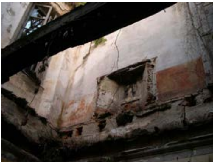
Fig. 6 - Villa Torri. Particolare. Tracce di quello che resta delle solette in legno crollate in una camera del corpo villa. Stato rilevato nel 2005.
